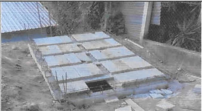
Foto 9: fosa séptica con pozo de absorción anexo
