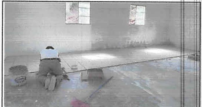
Foto 2: sustitución de torta de cemento por piso cerámico
