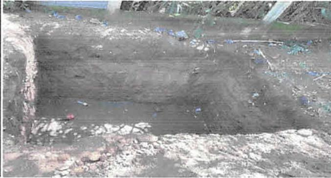
Foto 7: fosa séptica con pozo de absorción anexo
