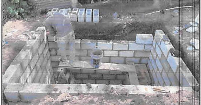
Foto 8: fosa séptica con pozo de absorción anexo
