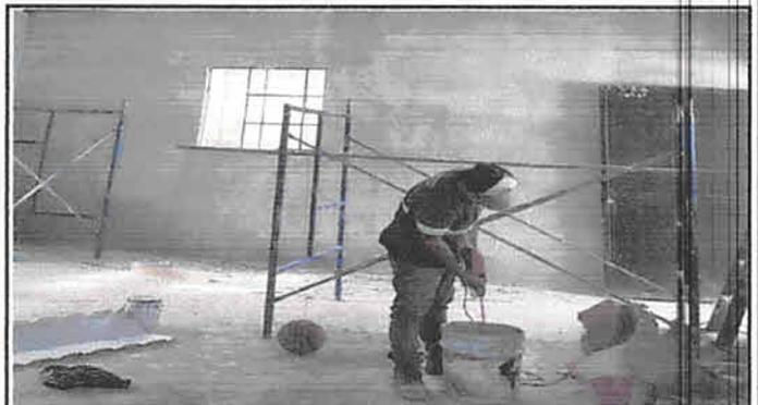
Foto 4: reparación de repello de muros de módulos
